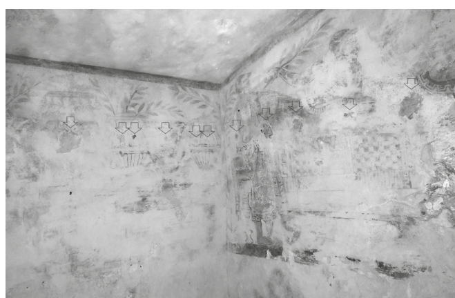
Fig. 3. Tamponature dei chiodi nell'angolo tra la parete sinistra e parete di fondo.
