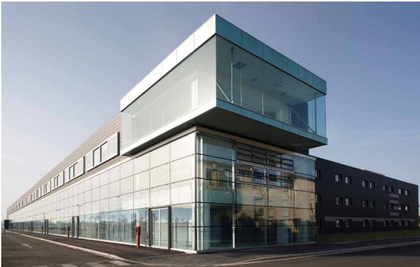
ARCHITETTURA PISANA Residenza universitaria loc. Praticelli, San Giuliano Terme, 2008 19
