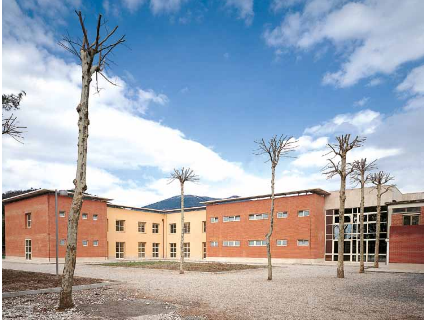
ARCHITETTURE PISANE 5-6 Ampliamento Polo Didattico San Giovanni alla Vena, Vicopisano
